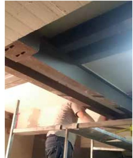
Reforço de estruturas de concreto armado com emprego de sistema estrutural metálico em edifício comercial
